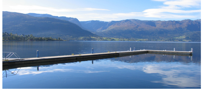
Gloppen Kommune, Sandane: Eksisterende betongbrygge forlenget med Ørsta Futura™ betongbrygge i L-form. Strøm, vann og redningsstige. (2010)
