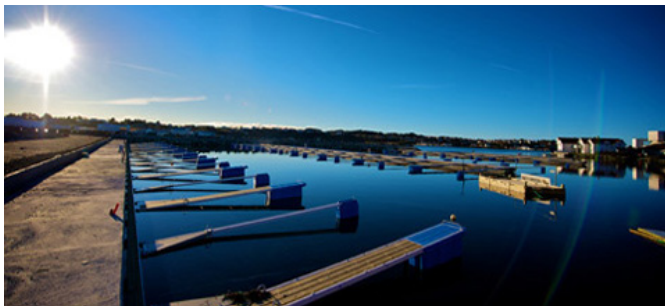
Rossabø Havn, Haugesund: 2 betongpiper med utriggere på begge sider og en rekke utriggere festet i kaikant med c-profilskinne. Totalt 75 båtplasser. (2010/2011)
