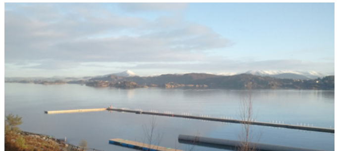
Gulenakken AS, Sotra: Trolig Norges lengste bølgedemper, 3 meter bred og 250 meter lang. Totalt 400 meter flytebrygger i betong og stål. Bølgedempere har rekkverk og badestiger. (2010/2011)
