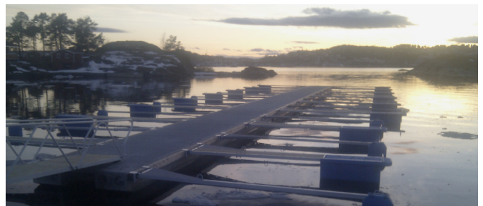
Sameiet Bærø, Kragerø: 2 betongpiper med bredde på 2,4 meter, tilsammen 40 båtplasser. (2011)
