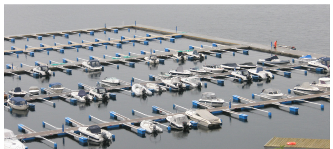
Kragerø Golf & Spa Resort: Bølgedemper i L-form, bredde 3,5m. Piper i betong- og stål på innsiden med utriggere på begge sider. (2005-2008)
