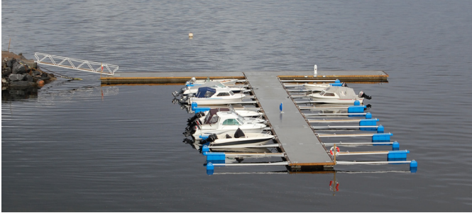
Klokkarbukta Båtlag, Gjemnes: T-brygge med pibredder på 3,5m og 2,7m. 6m utriggere og fortøyningsbommer. Strøm, vann og redningsstige. (2010)
